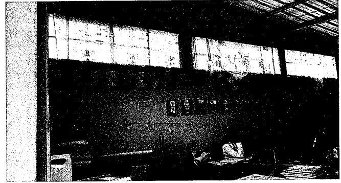
Foto 14: Sustitución de estructura de metal de ventana a pvc blanco mas balcon exterior
