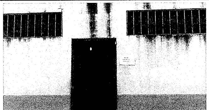
Foto 12: Mantenimiento a estructura (corte de puerta, lijado y pintura)
