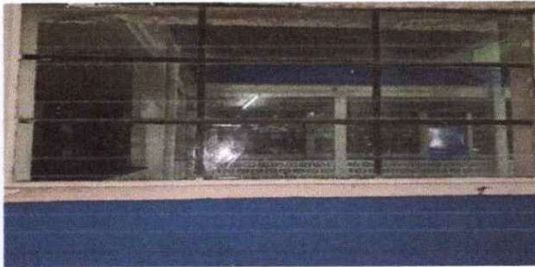
Foto 9: Sustitucion de vidrios de escuela que estan quebrados
