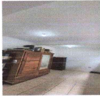
Foto 8: Aplicación de pintura general de oficina de supervision
