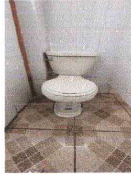
Foto Sustitución de inodoro en el primer nivel de maestros j. m
