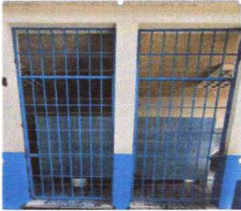
Foto 13: Instalación de rejas en sanitarios
