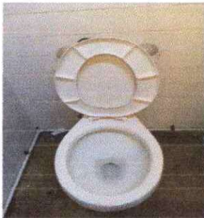
Foto 15: Instalación de inodoros en la jornada vespertina
