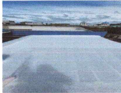
Foto , impermeabilización de área
