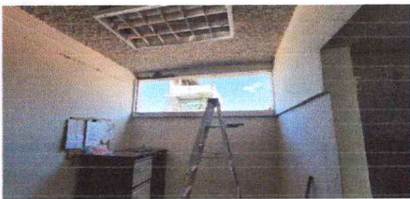
Foto 22. colocación de la ventana de pvc.
