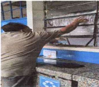
Foto 9: Sustitucion de vidrios de escuela que estan quebrados
