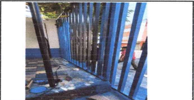
Foto 18: Se está instalando la reja de la entrada principal.
