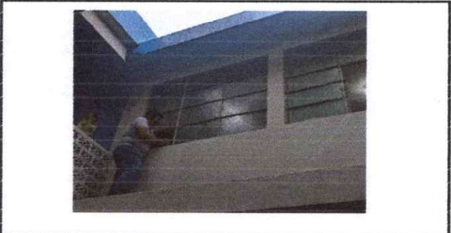
Foto 17: Modificando las ventanas del segundo nivel
