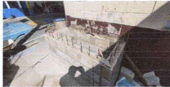
Foto 12: Fabricación de la pila.
