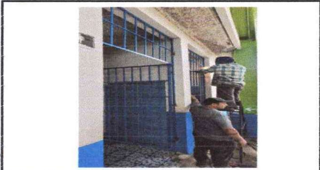
Foto 13: Instalación de rejas en sanitarios
