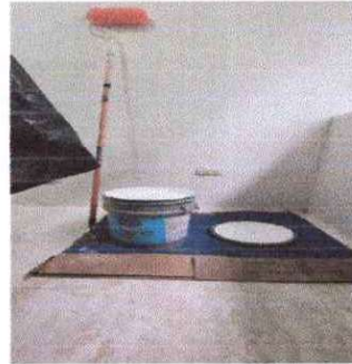
Foto 8: Aplicación de pintura general de oficina de supervision
