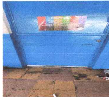
Foto 21: Guarda polvos instalando en las clases.
