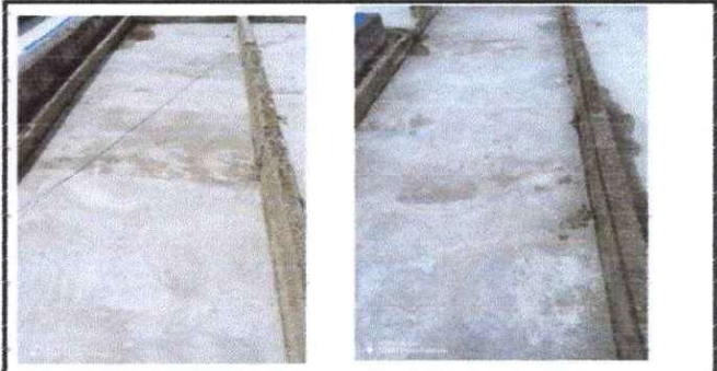
Foto 6: Limpieza y aplicación de impermeabilizante a losa de aulas de escuela 338 metros cuadrados
