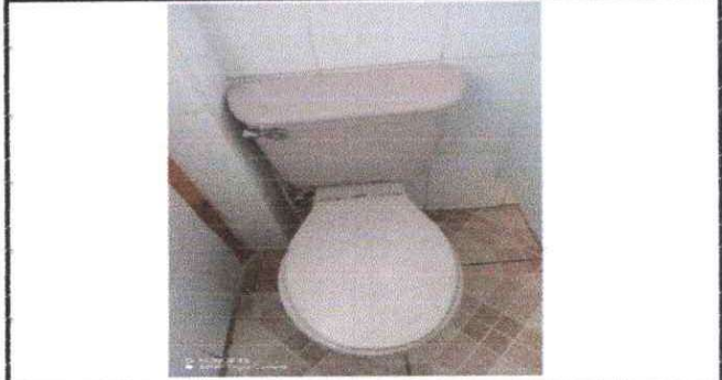
Foto Sustitución de inodoro en el primer nivel de maestros j. m
