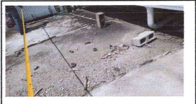
Foto 2: Remoción de mezon existente, limpieza y elaboración de pañuelos de mezon nuevos, impermeabilización de área
