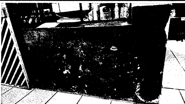
Foto 12: Cernido en muros, con aplicación de sika zero salitre más monotop
