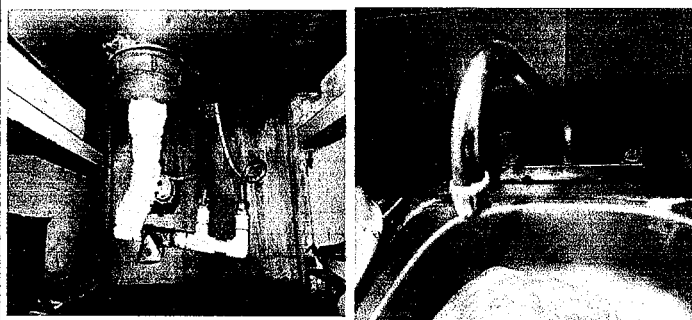
Foto 11: Reparación de lavatrastos y sustitución de accesorios y mezcladora
