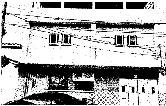
Foto 5: Reparación de frente, cernido, aplicación de sica Zero salitre y monotop. Pintura de exterior con pintura de revestimiento acrílico
