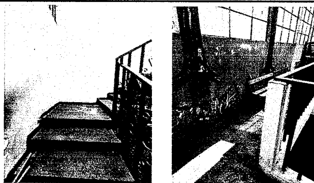
Foto 9: Instalación de puertas de rejas para bloquear acceso a gradas de segundo y tercer nivel
