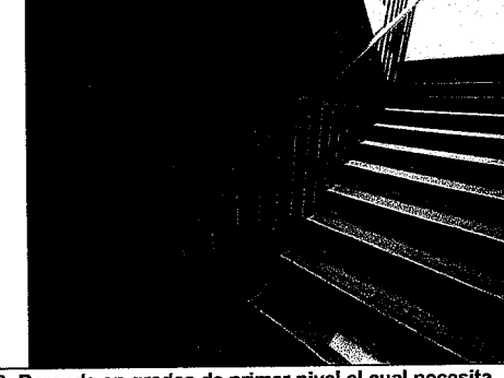
Foto 18: Baranda en gradas de primer nivel el cual necesita mantenimiento derivado del desgaste y oxidación del material.
