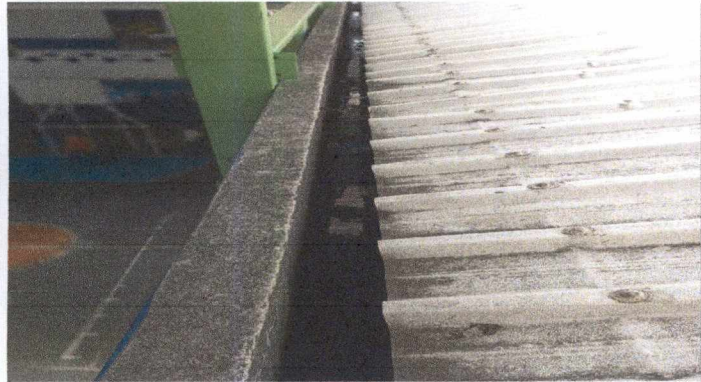
sustitución de cubierta de lamina, aluzin troquelada calibre 26 en salon para computación en segundo nivel con estructura
