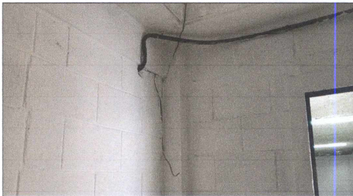
demolición de muro en ambas caídas de agua para hacer trabajos por instalaciones y colocación de canal en ambas caídas de agua del enlaminado existente para desviar el agua y nuevamente levantar el muro con columnas e incluye cernido (es necesario ya que no hay suficiente espacio entre pared y lamina para hacer los trabajos y no hay
