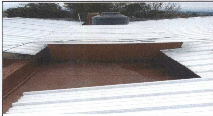
sustitución de cubierta de lamina, aluzin troquelada calibre 26 en salon para computación en segundo nivel con estructura
