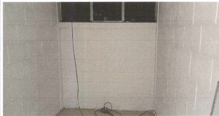
intalación de tomacorrientes para salon de computación incluye cableado
