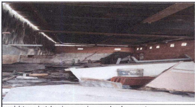
suministrar e instalar piso ceramico en salon de computo
