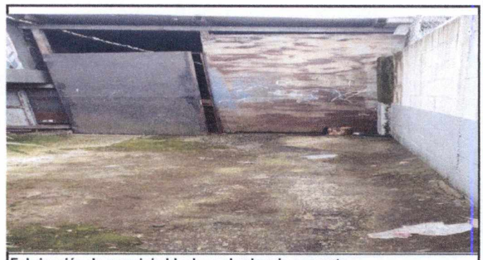
Fabricación de pared de block en el salon de computo
