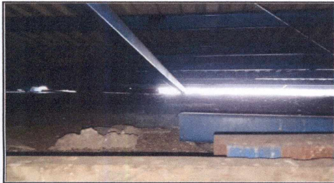
Instalación de lamina en la parte superior del salon de biblioteca por ingreso de palomas
