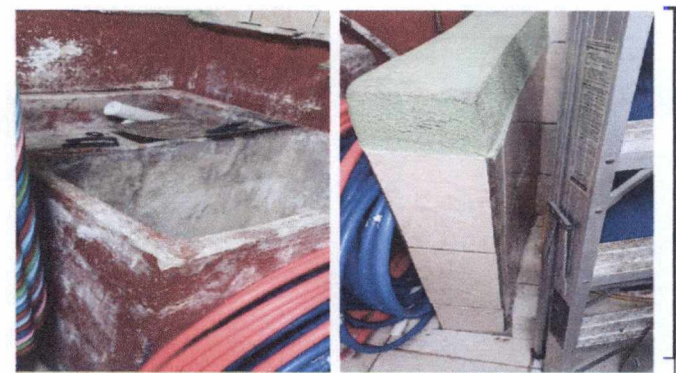
Demolición de pila y muro existente en cocina
