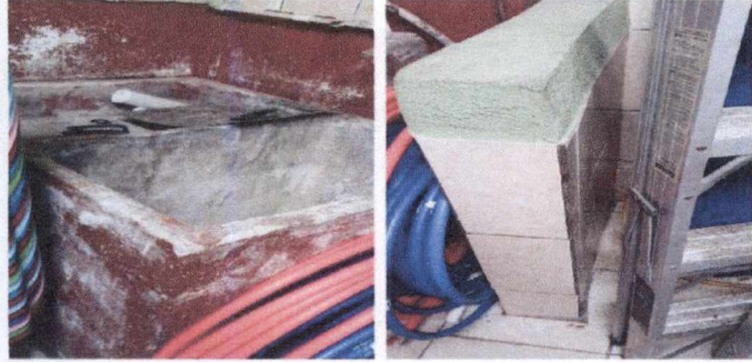
Fabricacion de pila fundida de dos lavaderos
