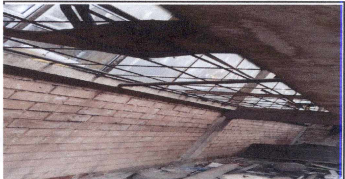
Colocación de tabla yeso en area de computación
