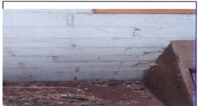
Pintar muros de biblioteca
