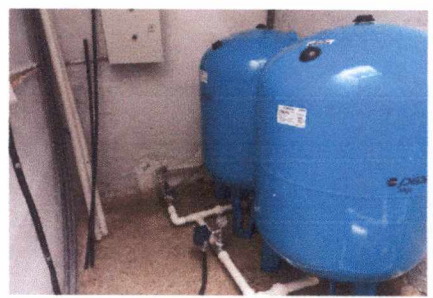
FOTO 4: SUSTITUCIÓN DE TANQUES HIDRONEUMÁTICOS
