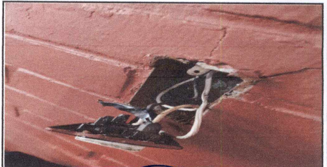
cambio de tomacorrientes dobles poralizados
