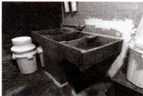
FOTO 7: DEMOLICIÓN DE PILA EXISTENTE E INSTALACIÓN DE DOS PILAS DE CONCRETO DE DOS LAVADEROS
