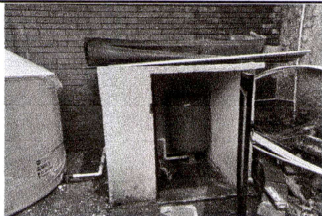
FOTO 9: FABRICACIÓN DE CASETA PARA BOMBA E HIDRONEUMÁTICO, INCLUYE INSTALACIÓN DE PUERTA DE METAL
