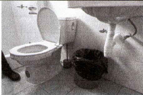
FOTO 5: SUSTITUCIÓN DE INODOROS Y ACCESORIOS EN LAVAMANOS. SUSTITUCIÓN DE PISO CERÁMICO.
