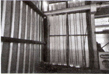
FOTO 1: INSTALACIÓN DE DOS LÁMINAS TROQUELADAS DE 8 PIES EN SEGUNDO NIVEL
