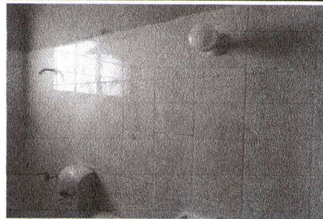
FOTO 4: INSTALACIÓN DE AZULEJO EN SERVICIOS SANITARIOS E INSTALACIÓN DE PLAFONERA CON BOMBILLA
