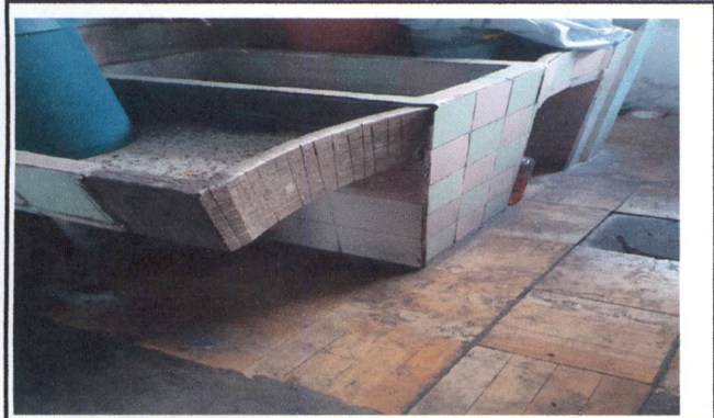
Foto 3: sustitucion de pila
