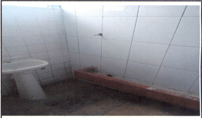
INSTALACION DE AZULEJO EN BAÑOS
