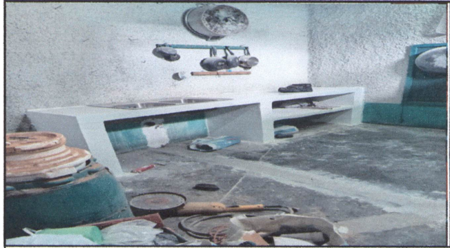
INSTALACION DE DRENAJE EN AREA DE COCINA INSTALACION DE TUBERIA DE AGUA POTABLE EN COCINA
