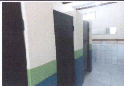
FOTO 4: MANTENIMIENTO A PUERTAS DE METAL EN SERVICIOS SANITARIOS
