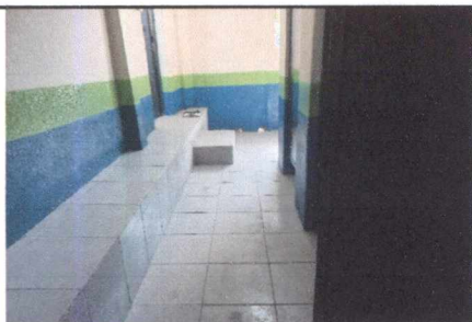
FOTO 5: INSTALACIÓN DE PISO CERÁMICO EN SERVICIOS SANITARIOS
