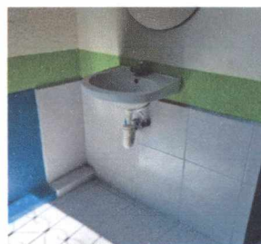
FOTO 6: INSTALACIÓN DE AZULEJO EN SERVICIOS SANITARIOS (PARA COMPLETAR 4M2 FALTANTES DE INSTALACIÓN DE PISO)
