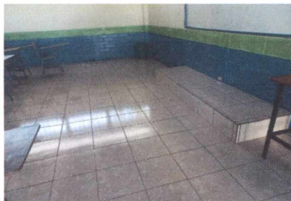
FOTO 2: INSTALACIÓN DE PISO CERÁMICO EN AULAS
