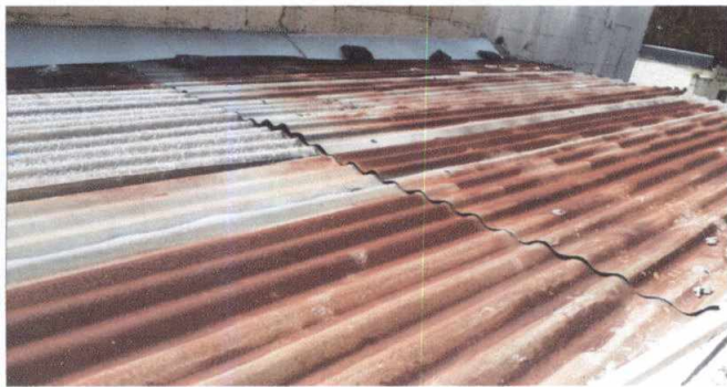
Foto 3: techo actual en sanitarios
