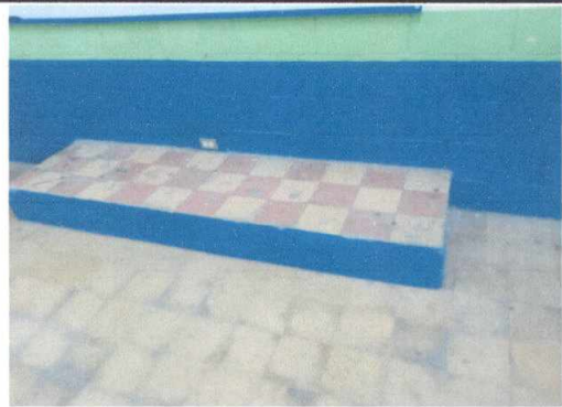
Foto 2: piso actual en aulas
