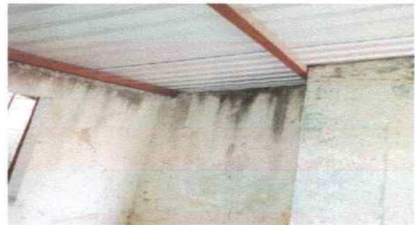
CUBIERTA DE LÁMINA
