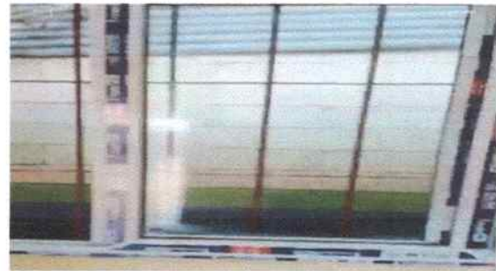
COLOCACIÓN DE VENTAS
