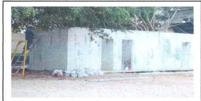
REPARACIÓN DE REPELLO
