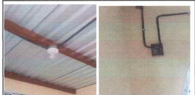
REPARACIÓN SISTEMA ELECTRICO
