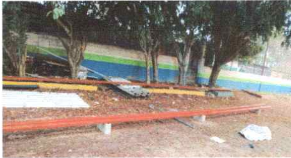
ESTRUCTURA DE TECHO
