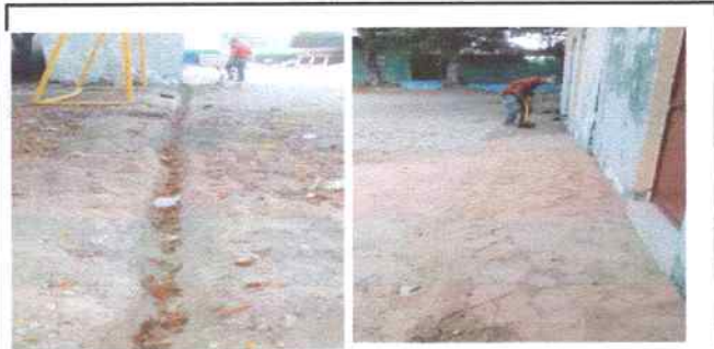
REPARACIÓN DE DRENAJES
