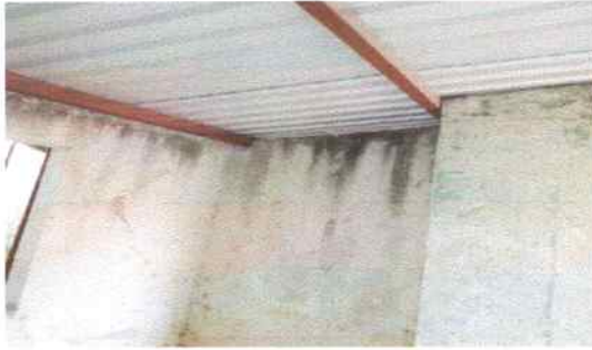
TECHO DE LAMINA
