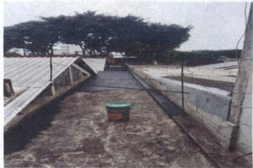
Foto 2: APLICACIÓN DE IMPERMEABILIZANTE
