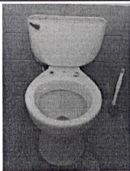
Foto 5: Sustitución de sanitarios
