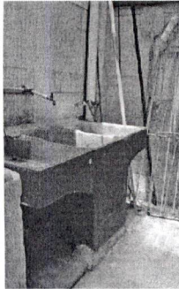
Foto 13: Instalación de pila
