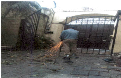
Foto 3: Mantenimiento a portones de metal
