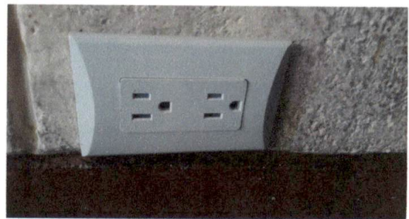
Foto 6: Sustitución de tomacorrientes dobles
