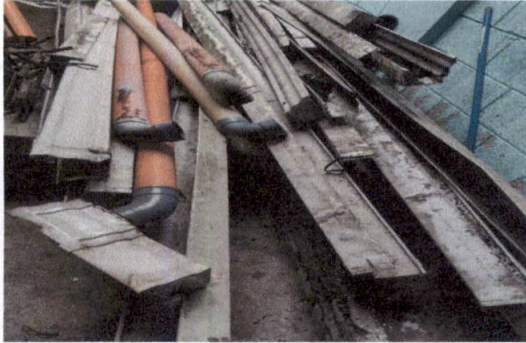
Foto 1: Sustitución de canal de pvc por lamina calibre 26
