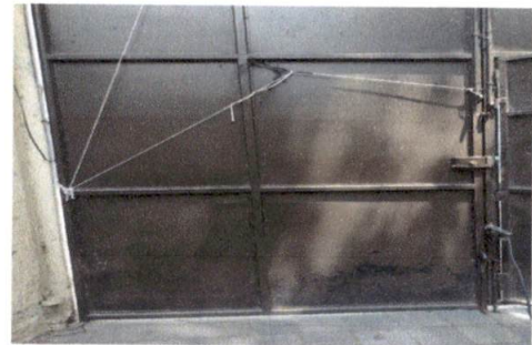
Foto 4: Sustitución de chapa
