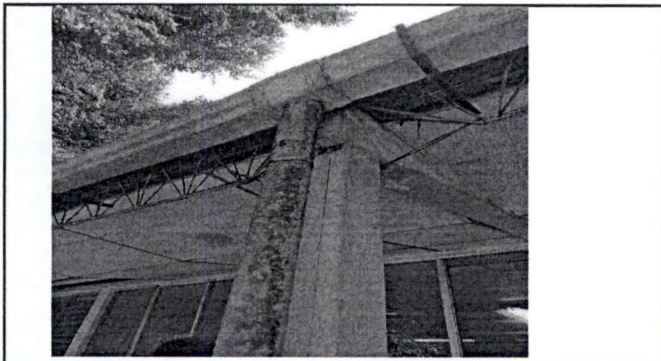
Foto 9: Sustrucción de canal de pvc por lámina calibre 26
