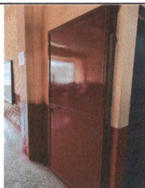
Foto 3: Pintado de puertas de aulas
