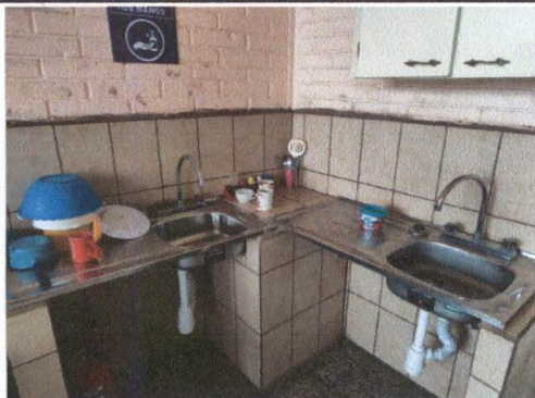
Foto 1: Cambio de lavatrastos en cocina.
