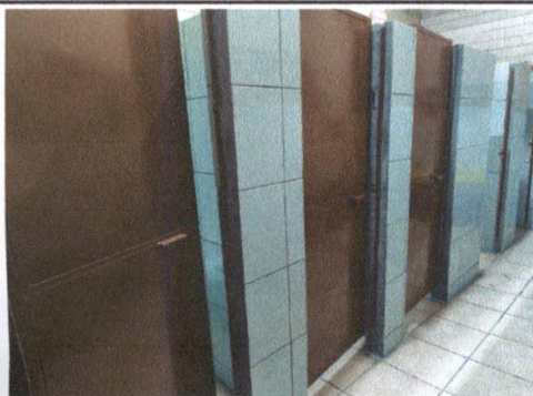
Foto 5: Cambio de Azulejo
