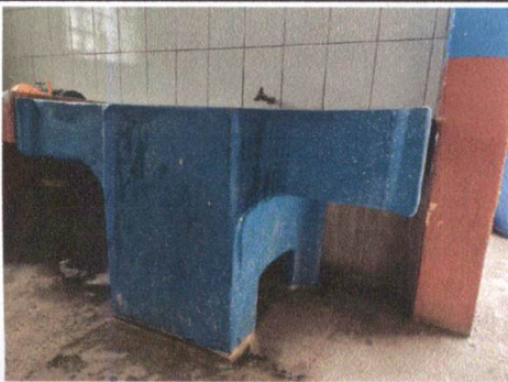
Foto 5: Cambio de pila
