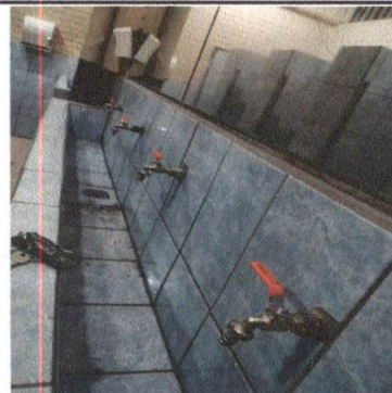
Foto 6: Cambio de Chorros de sanitarios
