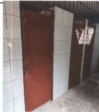
Foto 4: Cambio de puestas sanitarios de alumnas planta baja
