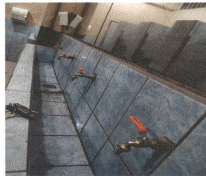
Foto 6: Cambio de Chorros de sanitarios
