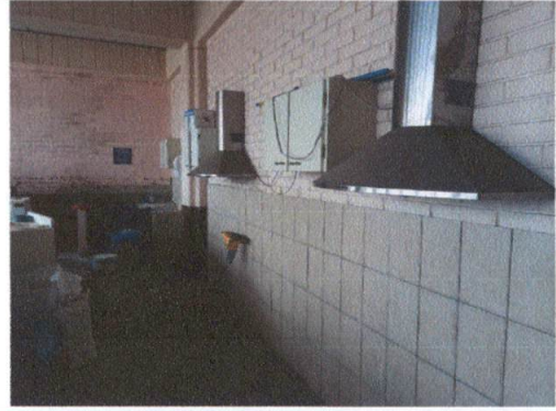
Foto 2: Cambio de azulejo en el area de cocina
