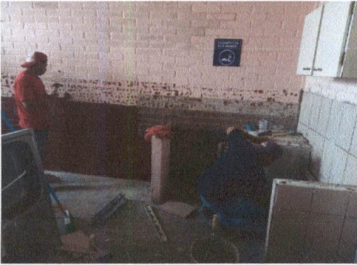
Foto 1: Cambio de lavatrastos en cocina.
