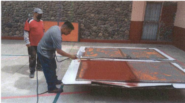
Foto 3: Pintado de puertas de aulas
