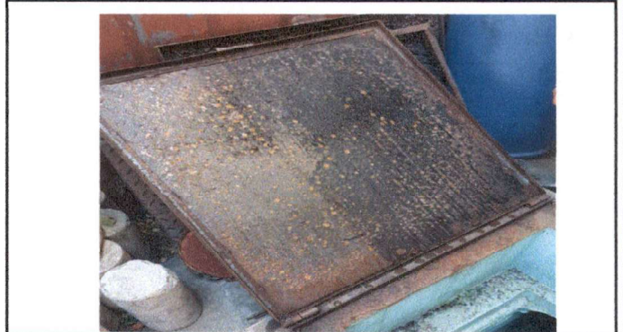
Foto 2: Remozamiento de Tapadera y pintura de cisterna
