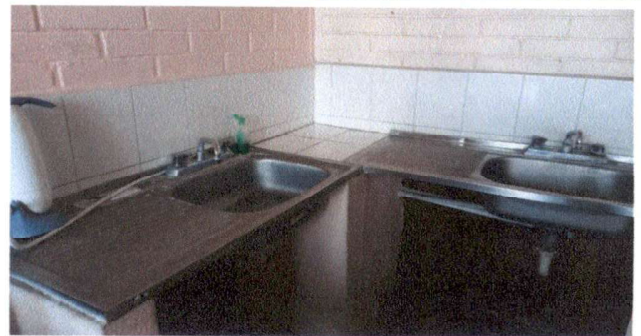
Foto 6: Cambio de Lavatrastos de area de cocina.
