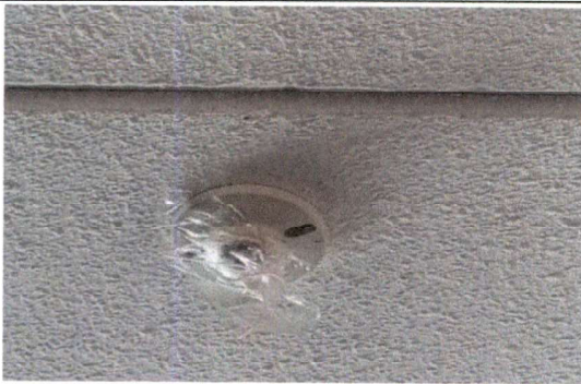
Foto 5: Reparación de flaponeras y colocar bombillas
