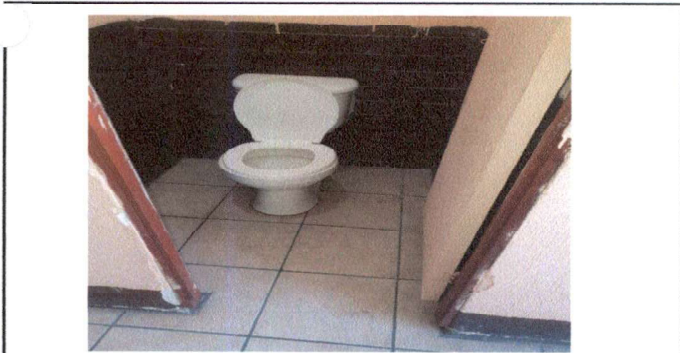
Foto 5: Cambio de puertas y sanitario, de maestros
