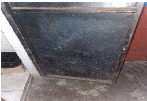
Foto 5: PUERTA DE SANITARIO PRIMER NIVEL
