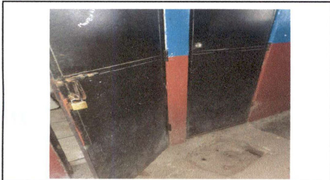
Foto 3: Cambio de puertas de baños primer nivel
