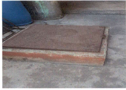
Foto 2: TAPADERA DE CISTERNA
