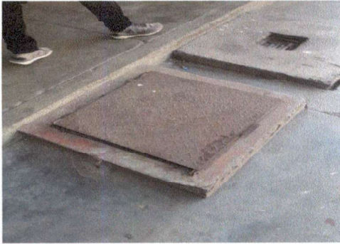
Foto 1: TAPADERA DE CISTERNA
