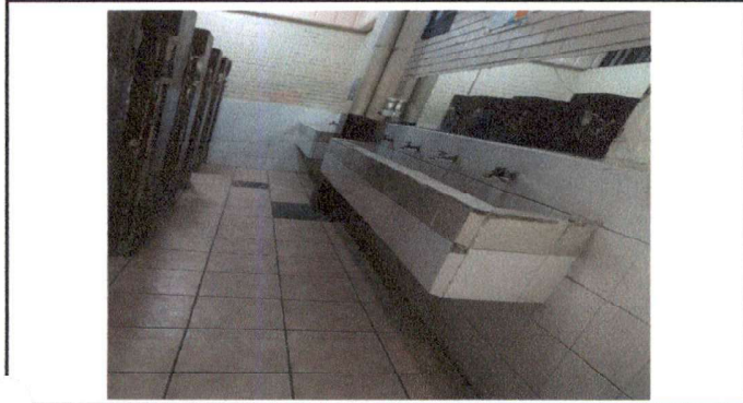
Foto 1: Cambio de azulejo y chorros , lavamanos
