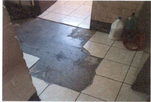
Foto 2: Reparación de Azulejo de Secretaria
