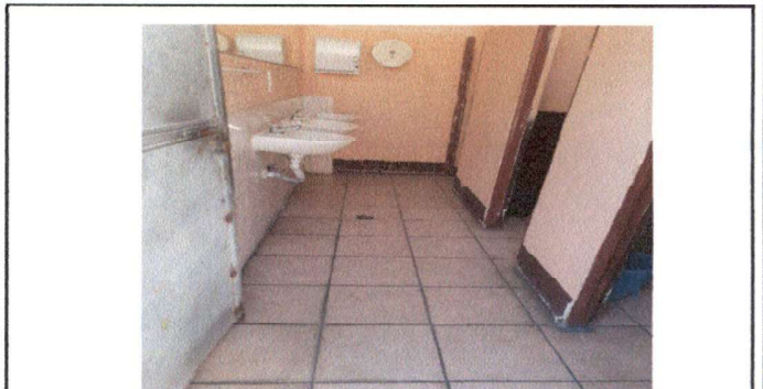
Foto 6: Cambio de puerta y lavamanos de baño de maestros
