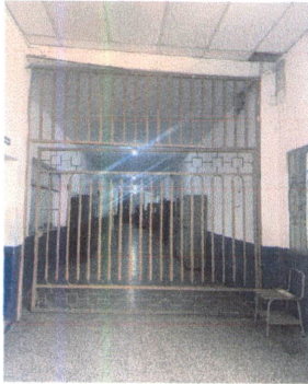
Foto 9: Mantenimiento a porton de reja (area corredor central)
