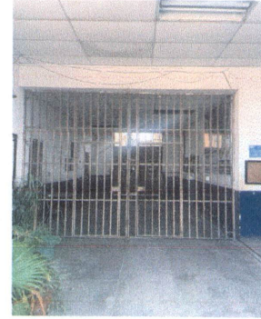
Foto 8: Mantenimiento a porton de reja (area entrada principal)
