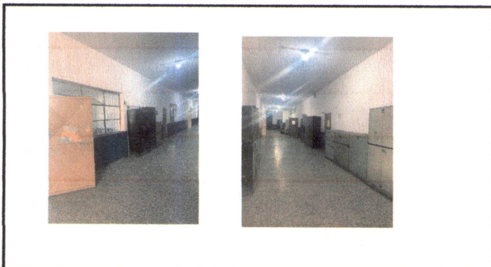
Foto 3: Puertas corredor central
