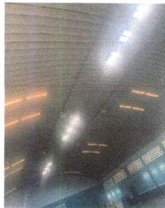
Foto 11: Sustitución de lamparas en el gimnasio
