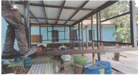
Foto 9: MÓDULO V - estructura interior espacio para cocina
