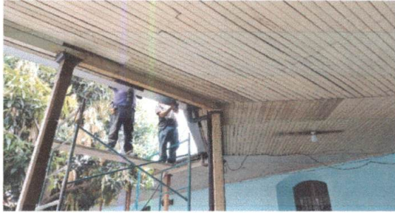
Foto 7: MÓDULO IV - Cambio de estructura y machimbre entrada 10ma. avenida.
