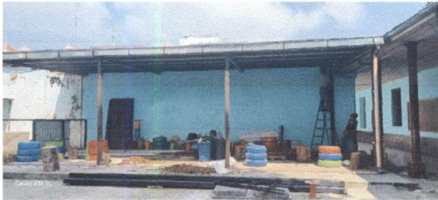
Foto 11: MÓDULO V - refuerzo de estructura portante de metal
