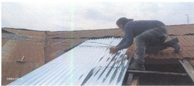
Foto 3: MÓDULO II - Cambio de lamina en corredor patio juntas civas
