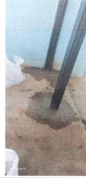
Foto 8: MÓDULO V - fundicion de parales para intalacion de puertas en cocina
