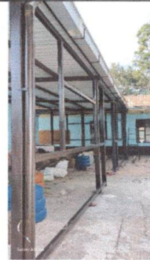
Foto 10: MÓDULO V - Aliniacion de postes en espacio de cocina.
