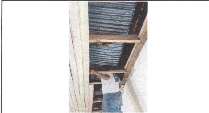
Foto1: MÓDULO I - Cambio de estructura de madera por madera.
