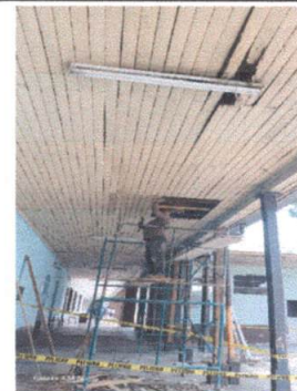
Foto 6: MODULO III - Cambio de machimbre en corredor patio juntas civas.
