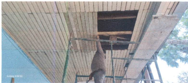
Foto 5: MÓDULO IV - Cambio de machimbre en corredor patio juntas civas.
