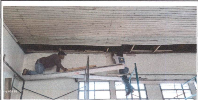
Foto 2: MÓDULO I - Cambio de estructura de madera por madera.
