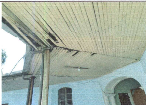
Foto 7: MÓDULO IV - Estado estructura y machimbre entrada 10ma. avenida.
