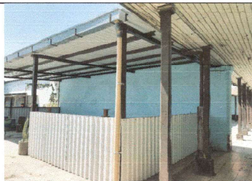
Foto 10: MÓDULO V - Frente de espacio para cocina intalacion de ventanas
