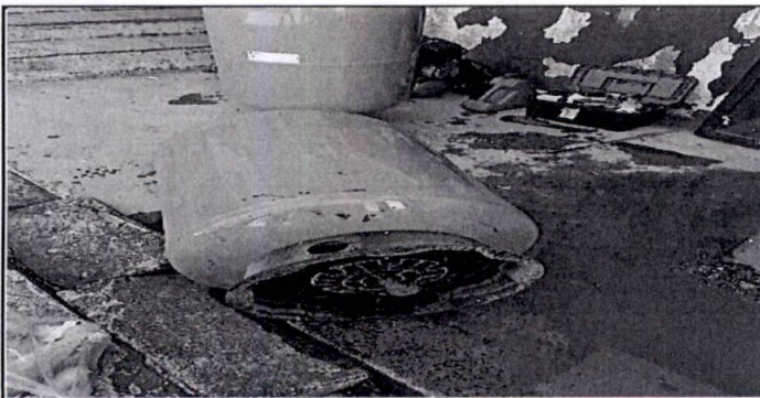
SUMINISTRO DE HIDRONEUMATICO
