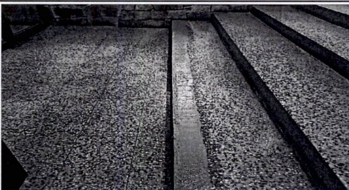
REPARACION DE GRADA DE INGRESO PRINCIPAL
