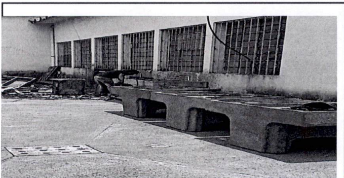
CAMBIO DE PILAS DE 2 LAVADEROS
