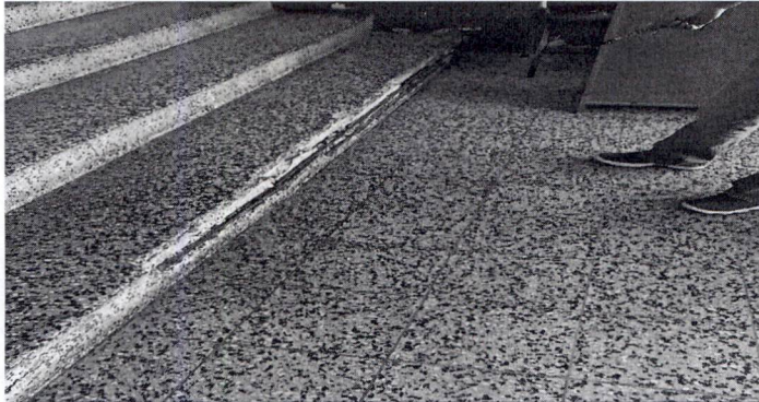
REPARACION DE GRADA DE INGRESO PRINCIPAL
