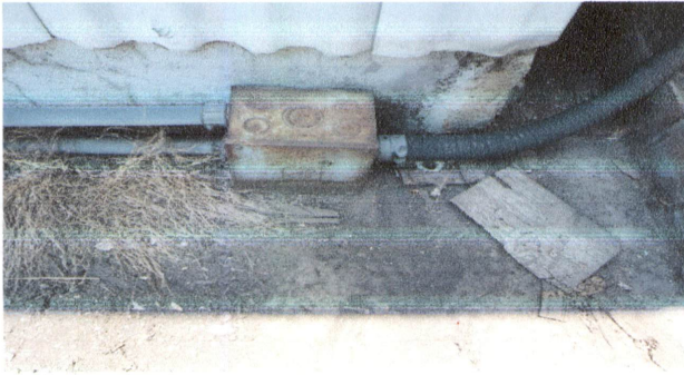
CAMBIO DE CAJAS DE REGISTRO
