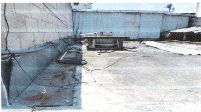
IMPERMEABILIZACIÓN DE LOZA
