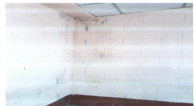
REVISION, LIMPIEZA, DESTAPE DE BAJADAS DE AGUA Y FABRICACIÓN DE CAJAS DE REGISTRO
