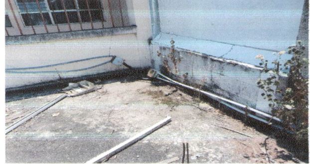
CAMBIO DE POLIDUCTO EXISTENTE
