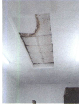
Foto 1: 9. Pintura y cernido a nivel de 1.90 m sobre camara de inodoros. Primera capa de cernido.
