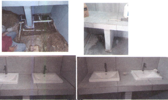
Foto 3: 10.3 Sustitución de 4 lavamanos. (los cuatro están instalados).
