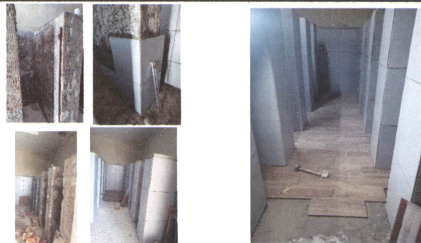
Foto 6. Sustitución de piso ceramico y azulejo en muros.
