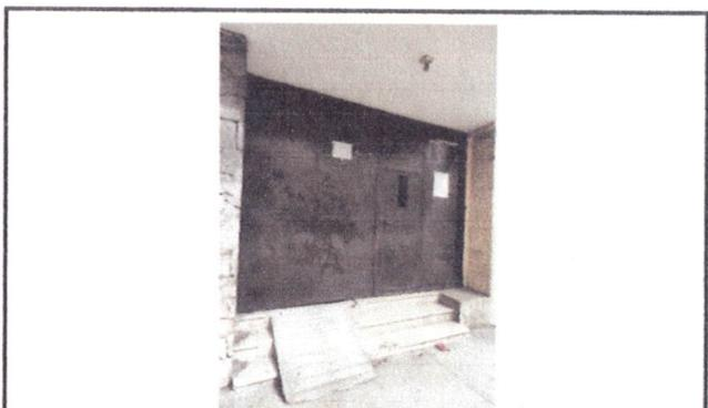
Foto 4. 4.1 Mantenimiento de portón de metal. Portón de ingreso mide 3.60 x 2.50 m (lijado, cambio de chapa, cepillado, sujeciones, aplicación de pintura megra de aceite).
