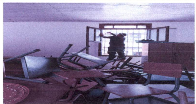
Foto 6: Inicio pintura de balcones
