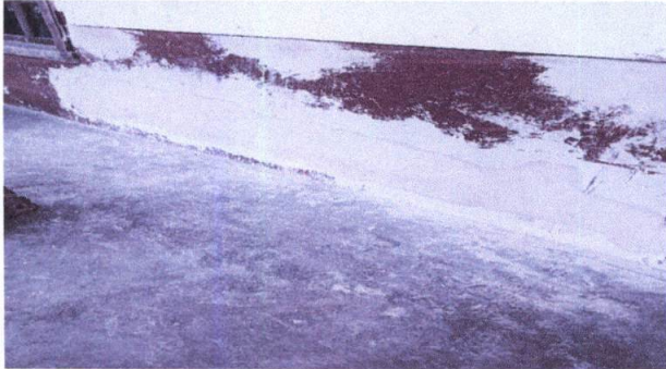
Foto1: Arreglo paredes corredor previo a pintar
