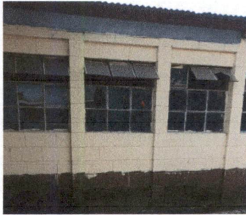
FOTO 1: Sustitución de vidrios
