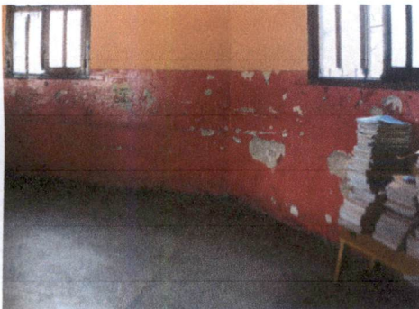
FOTO: PINTURA EN MUROS EXTERIORES E INTERIORES
