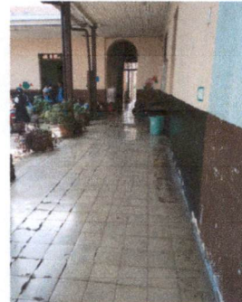
FOTO: PINTURA EN MUROS EXTERIORES E INTERIORES
