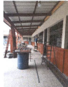
Foto 4: RENGLÓN "VENTANAS", EN PROCESO
