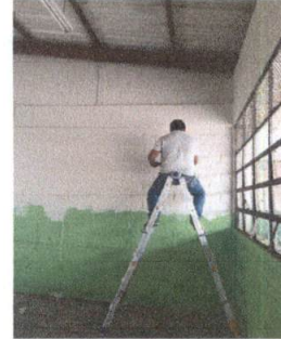
Foto 2: RENGLÓN PINTURA DE AULAS
