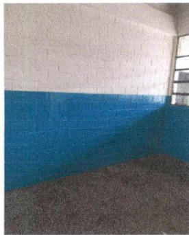
Foto 3: RENGLÓN PINTURA DE AULAS CONCLUIDO
