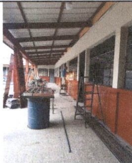
Foto 5: RENGLÓN "VENTANAS", EN PROCESO
