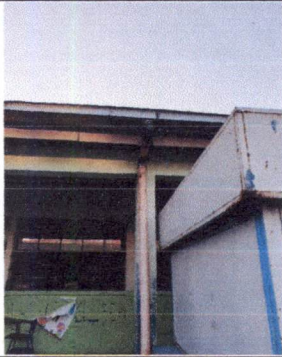
Foto1: RENGLÓN 7 "CANALES Y BAJADAS DE AGUA PLUVIAL"
