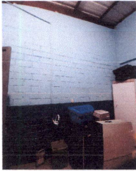
Foto1: RENGLÓN 20 "INSTALACIÓN DE AZULEJO, PLANCHA FUNDIDA DE CONCRETO Y ENTREPAÑO"
