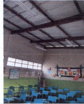
Foto 2: RENGLÓN 9 "PINTURA EN MUROS INTERIORES Y EXTERIORES"
