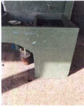
Foto3: RENGLÓN 20 "SUSTITUCIÓN DE PILA A DOS LAVADEROS"
