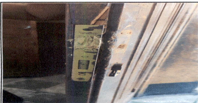
Foto 3: Cambio de chapas
