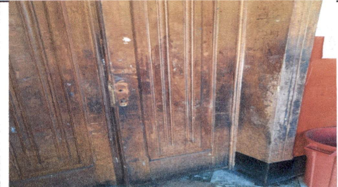
Foto 2. Mantenimiento de puertas madera
