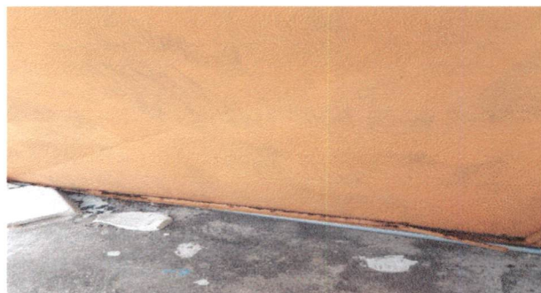
Foto 4: Mantenimiento en puertas
