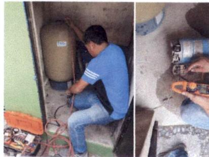
Foto 6: Mantenimiento de bomba de agua
