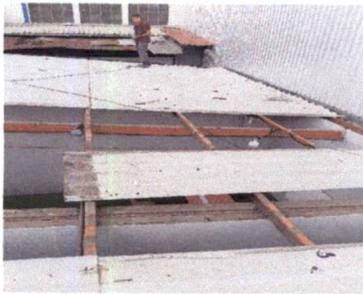
Foto 5: Mantenimiento de estructura metalica y cambio de lamina a azulec
