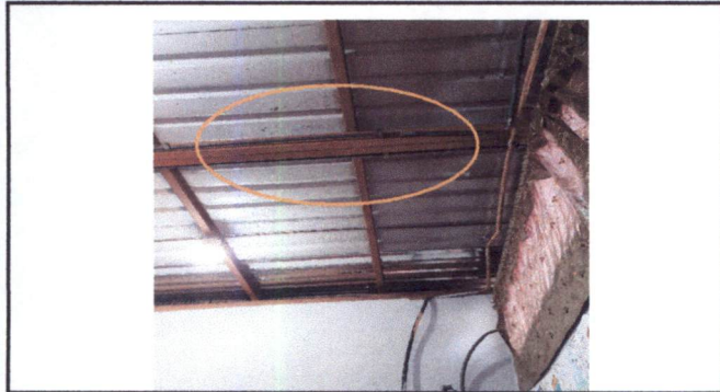
MODULO I: Mantenimiento de estructura metálica
