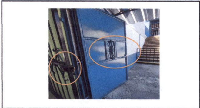
MODULO II: cambio de Puerta de ingreso y chapas de puertas
