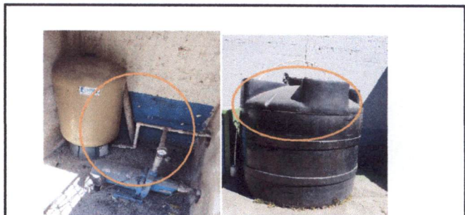
Modulo VI: Mantenimiento de cisterna y tinaco
