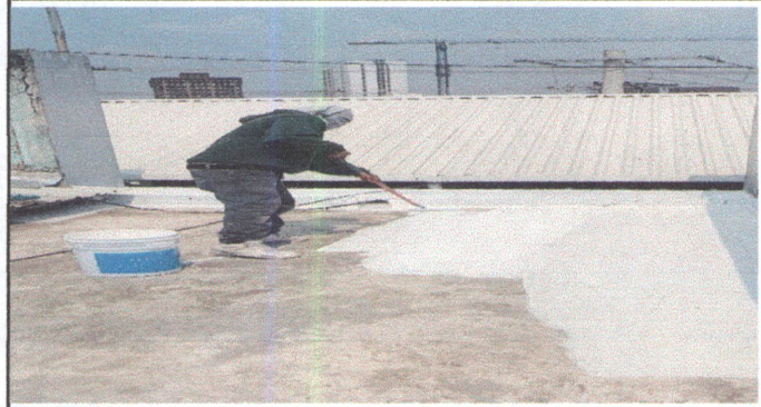
Foto1: IMPERMEABILIZACIÓN DE LOZA CORREDOR
