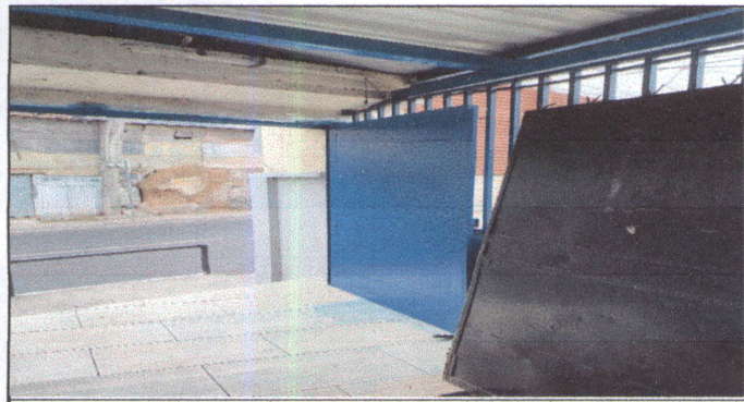
Foto 5: CAMBIO DE PORTON
