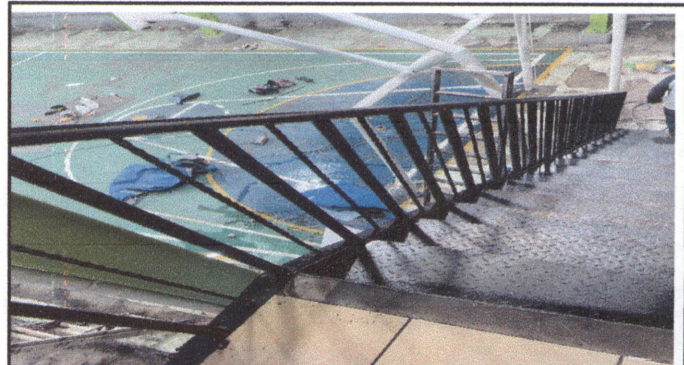
Foto 8: CAMBIO DE LAMINA DE GRADAS
