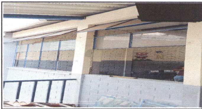
Foto 6: SUSTITUCIÓN DE ESTRUCTURA DE METAL Y VENTANA
