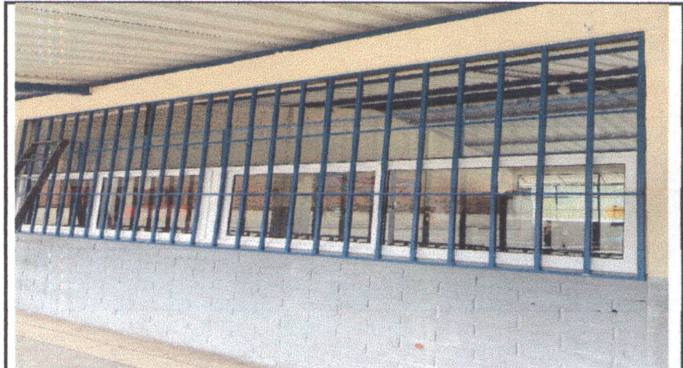
Foto 4: COLOCACIÓN DE BALCONES
