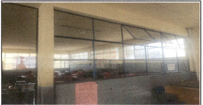
Foto 4: CUARTO "A" SUSTITUCIÓN DE ESTRUCTURA DE METAL Y VENTANA
