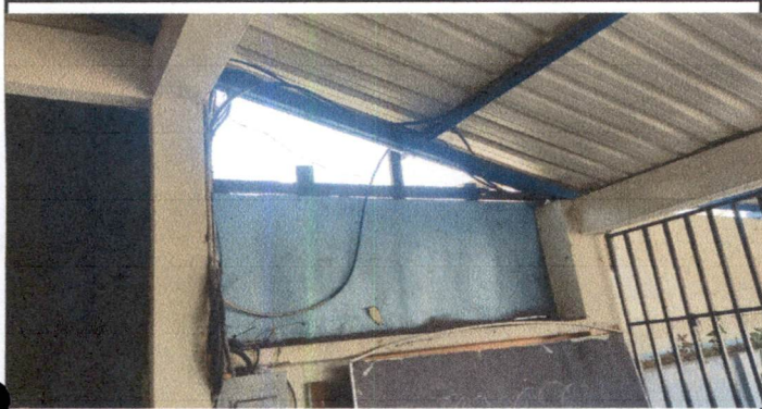
Foto 7: SUSTITUCIÓN DE ESTRUCTURA DE METAL VENTANA CORREDOR
