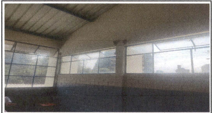
Foto 10: CUARTO "B" SUSTITUCIÓN DE ESTRUCTURA DE METAL VENTANA Y BALCON .
