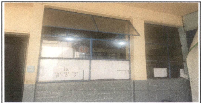
Foto 12: PRIMERO "A" SUSTITUCIÓN DE ESTRUCTURA DE METAL VENTANA Y BALCON
