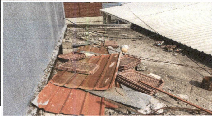
Foto 1: IMPERMEABILIZACIÓN DE LOZA CORREDOR
