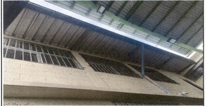
Foto 2: SUSTITUCIÓN DE CANAL DE METAL
