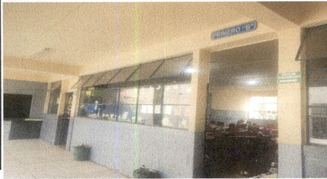
Foto13: PRIMERO "B" SUSTITUCIÓN DE ESTRUCTURA DE METAL Y VENTANA
