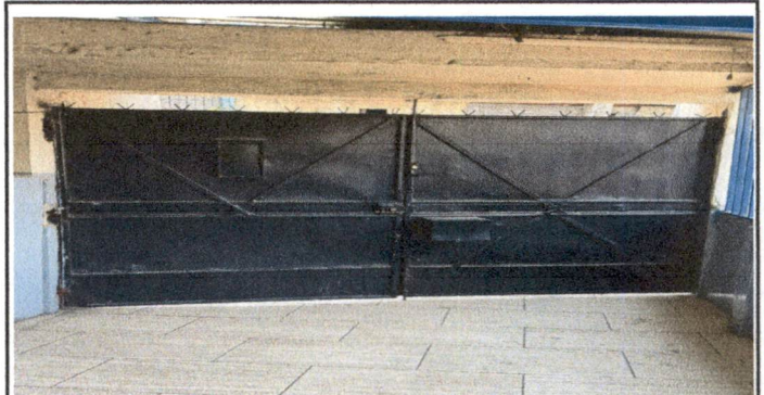
Foto 16: SUSTITUCION DE PUERTA DE METAL
