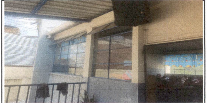
Foto 6: SUSTITUCIÓN DE ESTRUCTURA DE METAL Y VENTANA
