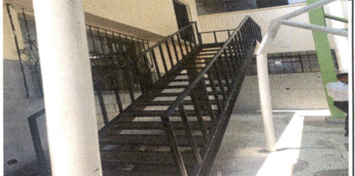
Foto 6: MANTENIMIENTO DE GRADAS DE METAL TIPO LABRADA
