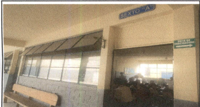
Foto 9: SEXTO "A" SUSTITUCIÓN DE ESTRUCTURA DE METAL VENTANA Y BALCON .
