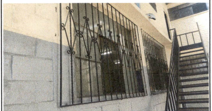
Foto 14: PRIMERO"C" SUSTITUCIÓN DE ESTRUCTURA DE METAL Y VENTANA
