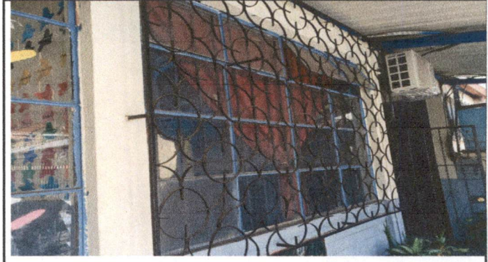
Foto 8: SUSTITUCIÓN DE ESTRUCTURA DE METAL VENTANA Y BALCON DIRECCIÓN MATUTINA.
