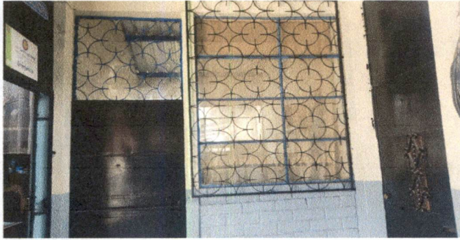
Foto19: SUSTITUCIÓN DE ESTRUCTURA DE METAL Y VENTANA DIRECCIÓN DE LA JORNADA VESPERTINA
