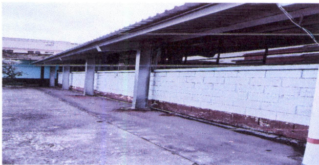
Foto 3: Estructura metálica del techo.
