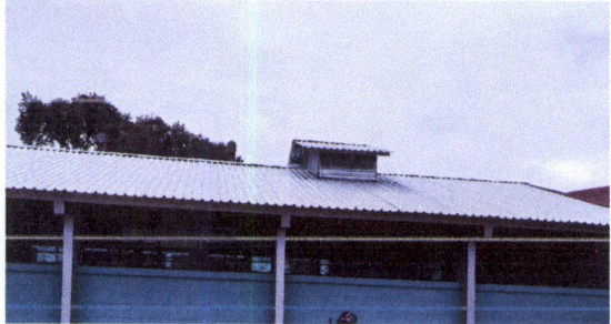
Foto 1: Cambio de techo
