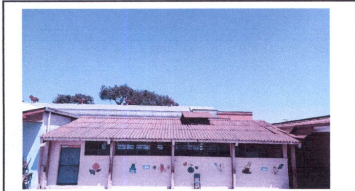
FOTO 1: TECHO DE AULA
