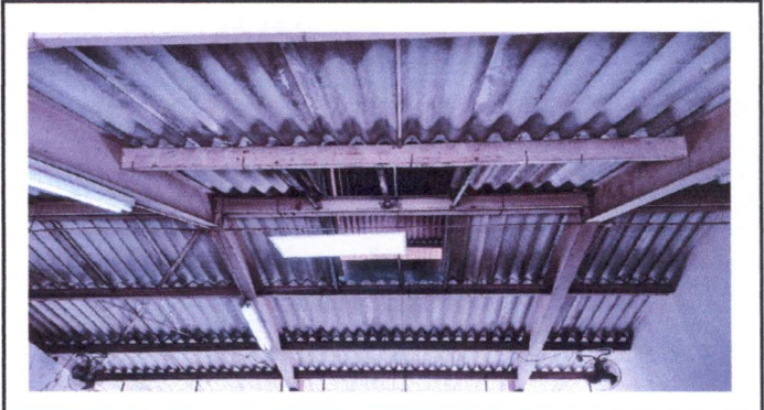
FOTO 2: ESTRUCTURA DEL TECHO
