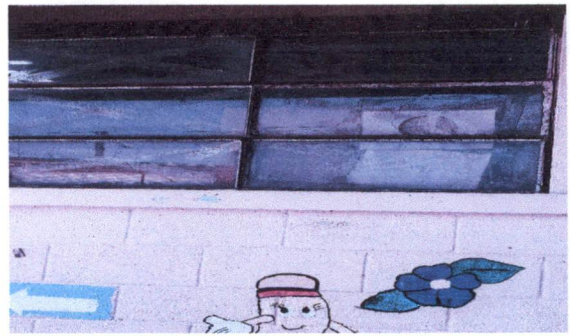
FOTO 6: ESTRUCTURA DE VENTANA
