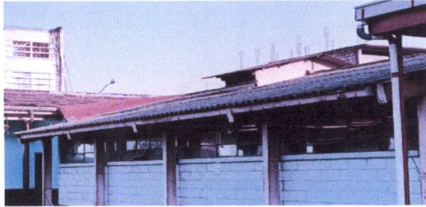
FOTO 1: TECHO DE AULA
