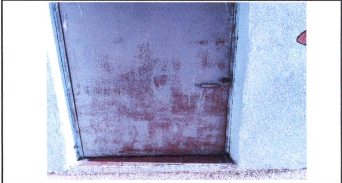
FOTO 4: PUERTA DE METAL
