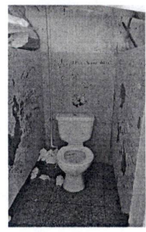
FOTO 10: Reparación de inodoros y cambio de accesorios
