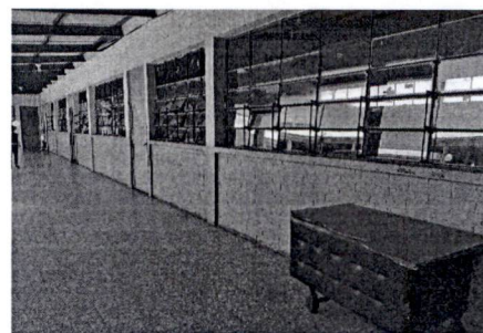
Foto 4: PINTURA EN MUROS EXTERIORES Y SALÓN DE ACTOS
