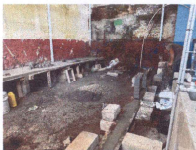
APLICACIÓN DE PINTURA EN MUROS DE COCINA
