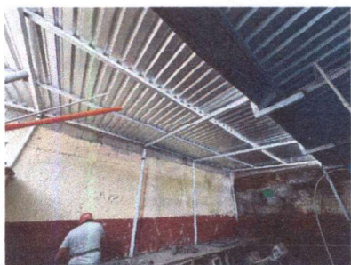
INSTALACIÓN DE AZULEO EN LA PARTE SUPERIOR E INSTALACION DE UN LAVATRASTOS
