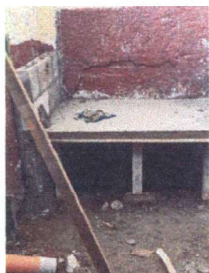
INSTALACIÓN DE DRENAJE Y AGUA POTABLE PARA COCINA
