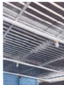
INSTALACIÓN DE BOMBILLA LED EN COCINA Y CORREDOR
