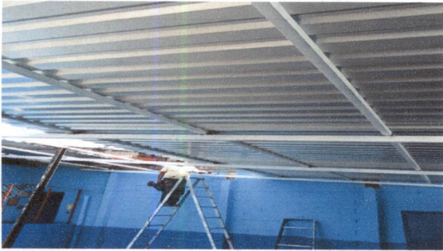
Foto 1: instalación de la estructura del techo del patio
