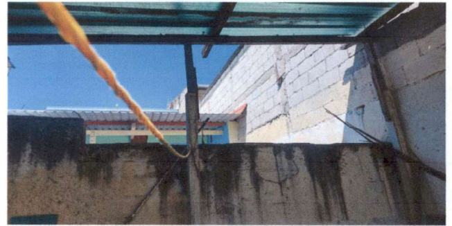
Foto 4: Colocación de una ventana en cocina.
