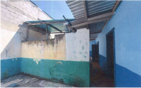
Foto1: Estructura del techado en cocina.
