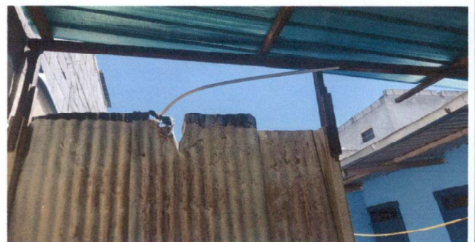
Foto 6: Cambio de estructura de paredes y techado en cocina.
