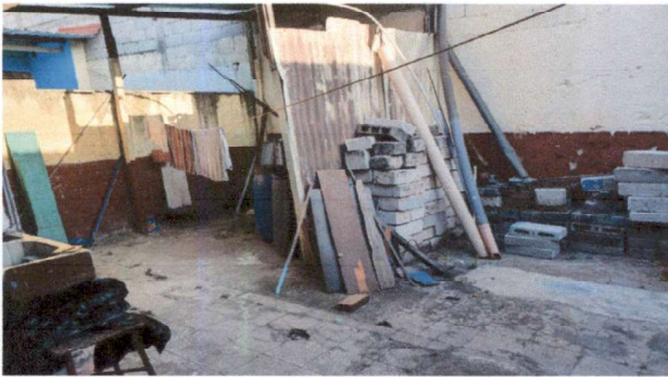
Foto 3: Nivelar el piso y pintura de paredes
