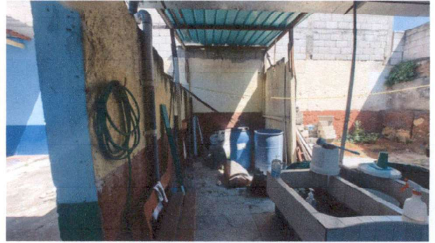
Foto 2: Cambio de estructura para la cocina
