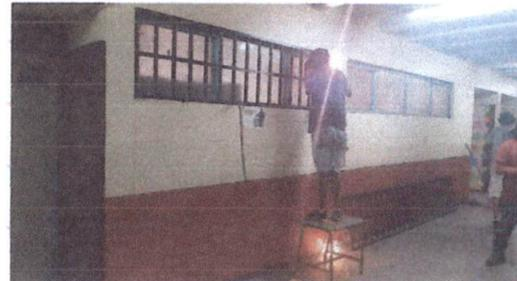
Foto 6: Instalación de balcones en planta baja
