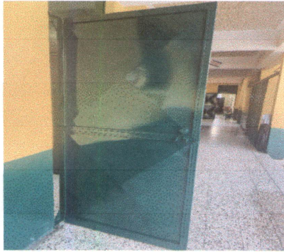
Foto 1 Mantenimiento a estructura de puerta de metal
