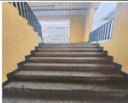
Foto 8 Pintura a muros exteriores
