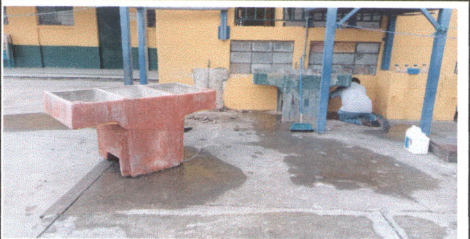
Foto 18 Sustitución de pila de cemento de dos lavaderos.
