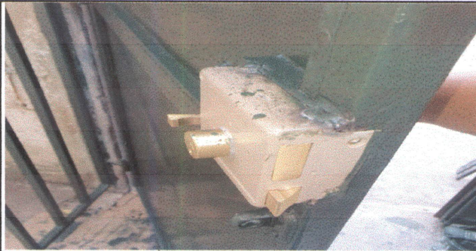
Foto 3 Sustitución de chapa de portón
