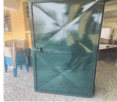
Foto 2 Mantenimiento a estructura de puerta de metal
