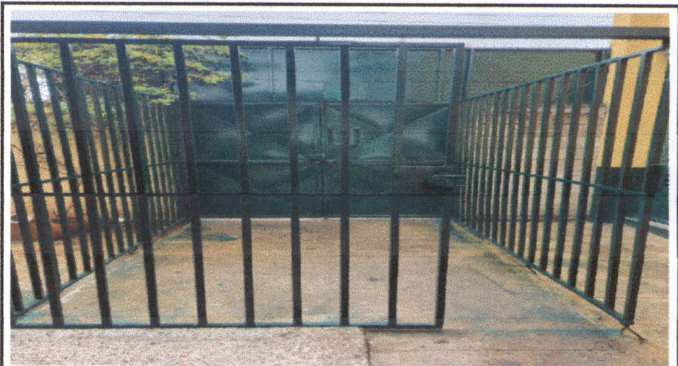
Foto 14 Mantenimiento a rejas
