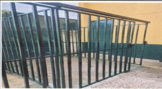
Foto 13 Mantenimiento a rejas
