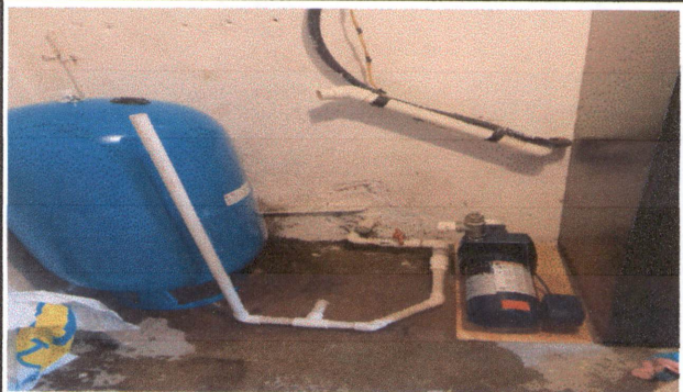
Foto 16 Sustitución de bomba de agua star-rite y sistema accesorio, hidroneumático.
