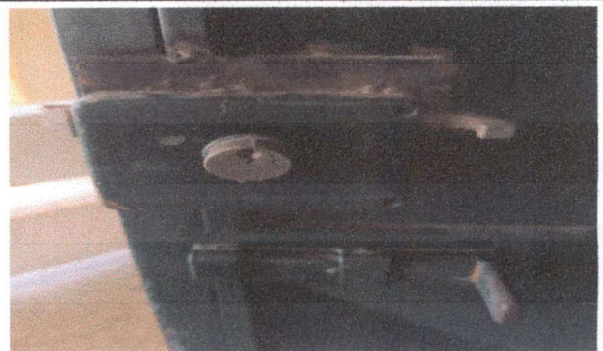
Foto 4 Sustitución de chapa a puerta de clase
