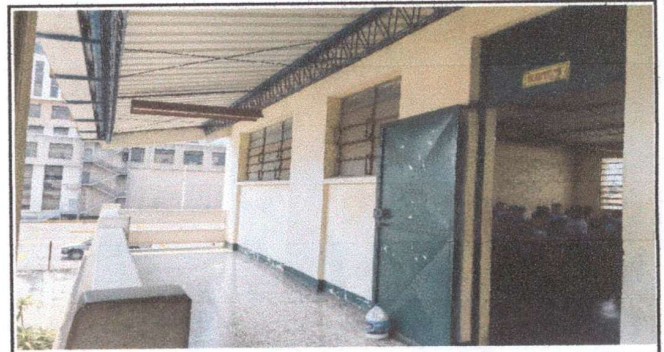
Foto 10 Pintura de muros exteriores e interiores
