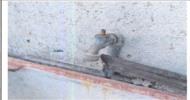
Foto 15 Sustitucion de llave de chorro
