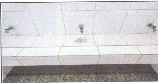
Foto 11 Sustitución de grifos
