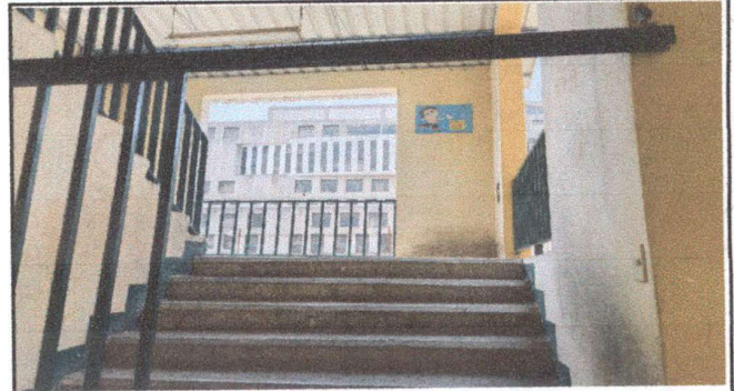
Foto 8 Pintura en muros exteriores
