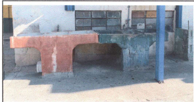
Foto 18 Sustitución de pila de cemento de dos lavaderos.
