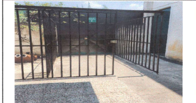
Foto 14 Mantenimiento a rejas
