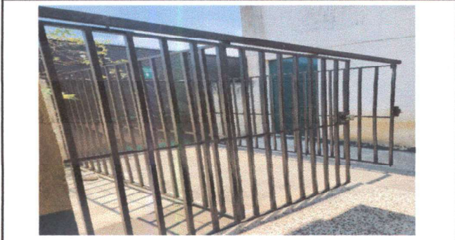
Foto 13 Mantenimiento a rejas
