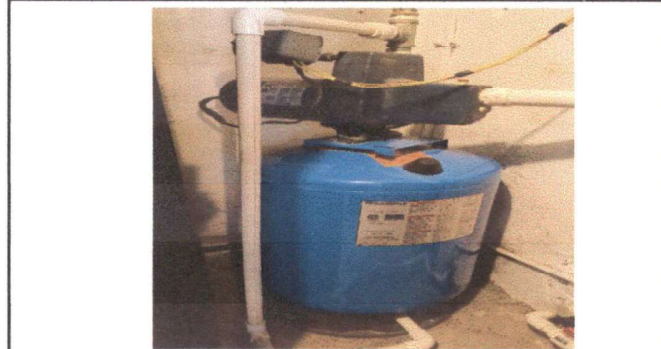
Foto 16 Sustitución de bomba de agua star-rite y sistema accesorio, hidroneumático.
