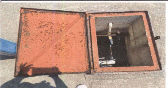
Foto 17 Limpieza e impermeabilización de Cisterna
