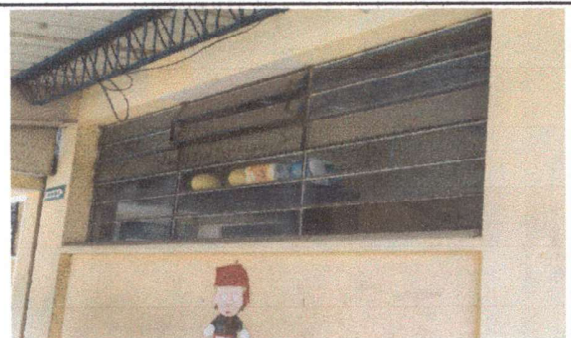
Foto 6 Mantenimiento a estructura de metal de ventana
