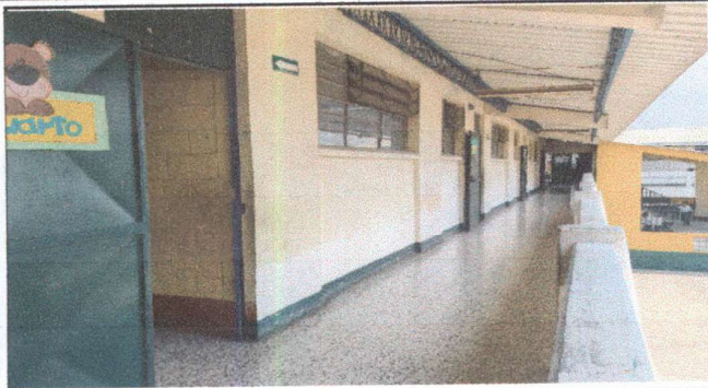
Foto 7 Pintura en muros exteriores
