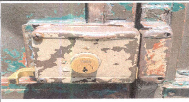
Foto 3 Sustitución de chapa portón
