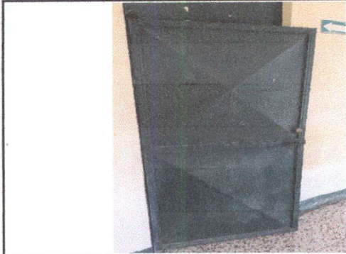
Foto 1 Mantenimiento a estructura de puerta de metal
