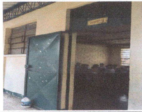
Foto 2 Mantenimiento a estructura de puerta de metal
