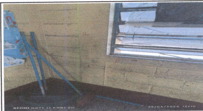
Foto 9 Pintura de muros interiores
