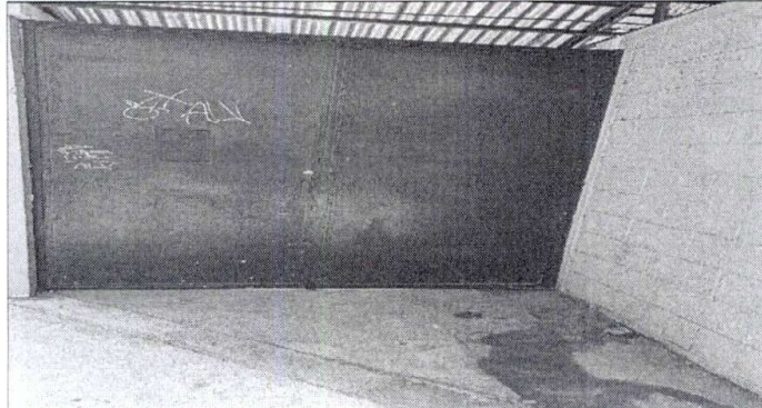
Reparación de portones de 2 bandas sobre avenida junto a la cancha
