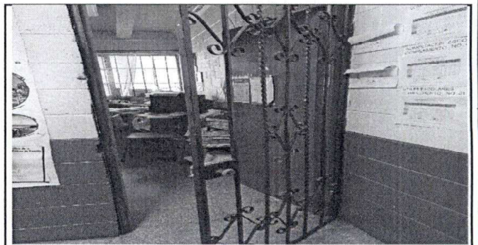
Reparación puerta de rejas más pintura en dirección JV
