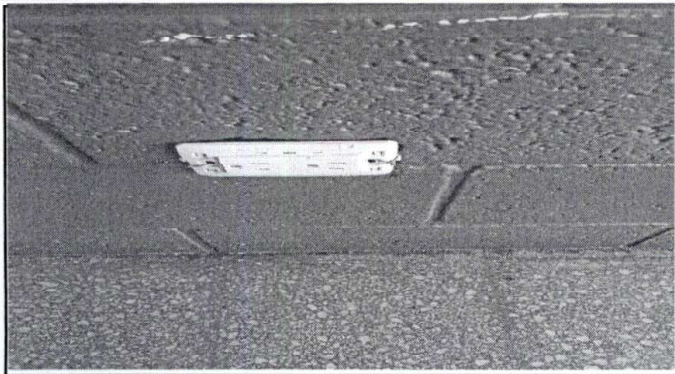
Cambio de Toma Corriente Doble
