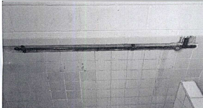
Reparación de Urinal (cambio de llave y tubería) en sanitarios JM
