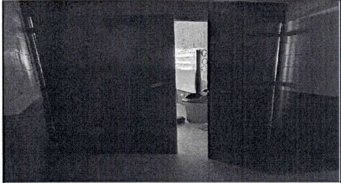
Cambio de Puertas de 2 bandas para las aulas
