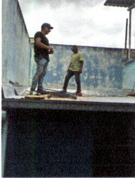
Foto1: Sustitucion de lámina, por lámina troquelada aluzinc calibre 26
