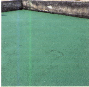
Foto 3: Impermeabilización de losa
