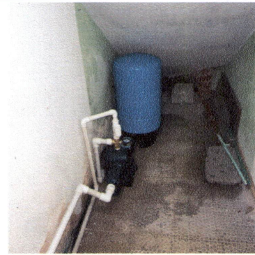
Foto 10: REPARACION Y MANTENIMIENTO DE CISTERNAS/DEPOSITOS DE AGUA
