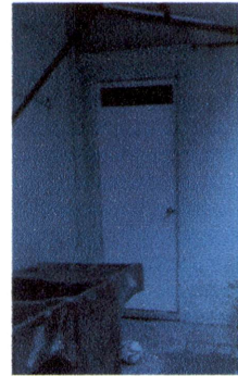
Foto 4: Sustitución de puerta de en servicio sanitario
