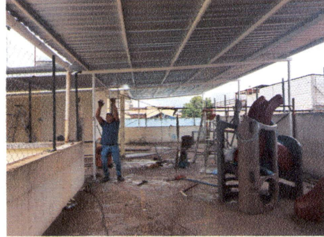
Foto 8: Reparacion de tubo hg y malla galvanizada
