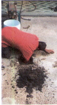
Foto 7: REPARACION DE RED DE DRENAJE Y RED DE AGUA POTABLE
