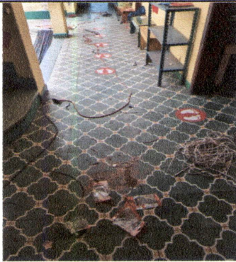
Foto 9: REPARACION DE SISTEMA ELECTRICO
