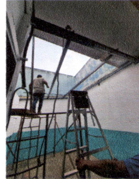
Foto 2: ESTRUCTURA DE TECHO
