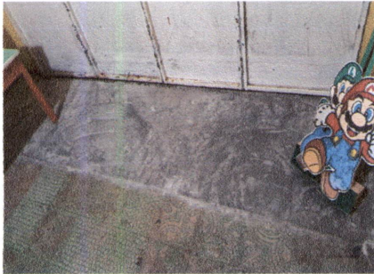
Foto 5: Reparación de piso de torta de concreto
